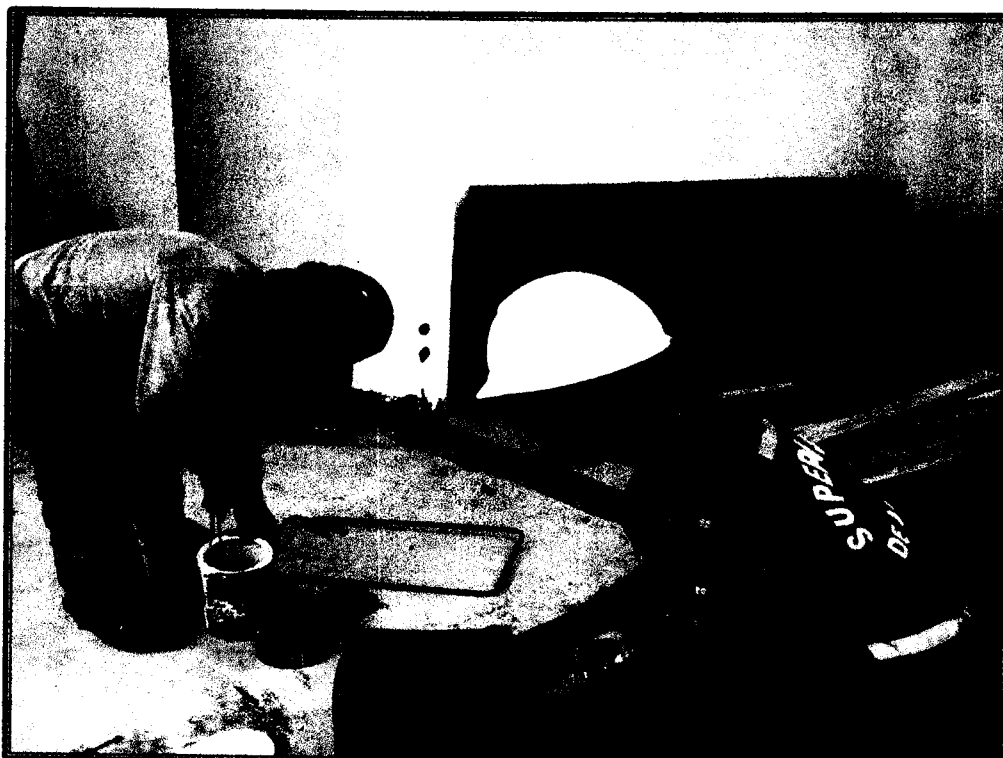
VERIFICACION DE LA COLOCACION DE ADITIVO EPOXICO SIKADUR 32
