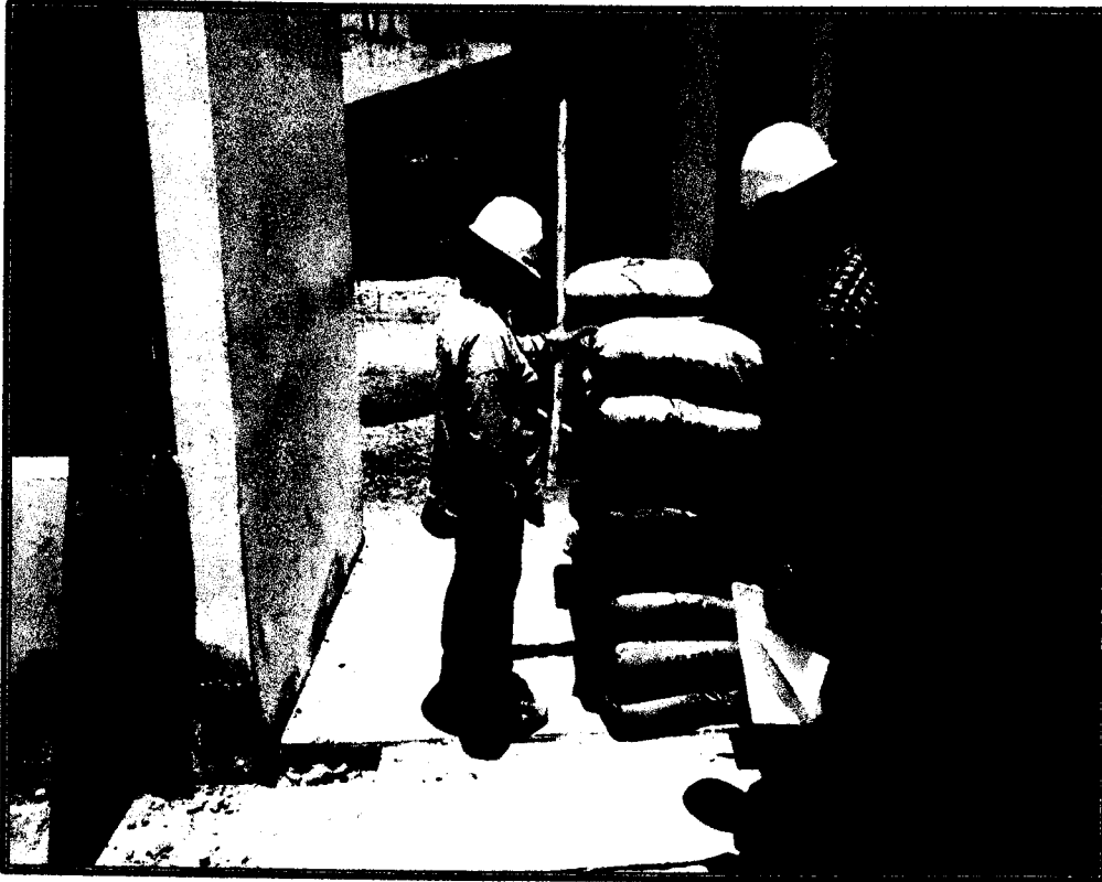
CONTROL DE ALMACENAMIENTO DE CEMENTO
