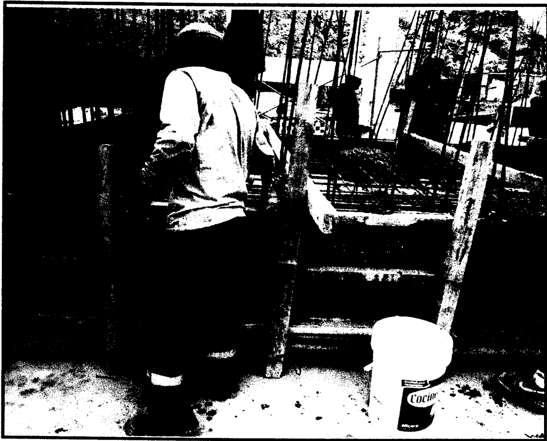
Fotografía N° 09. vaciado de concreto f'c=280\text{kg/cm}^2 en vigas
