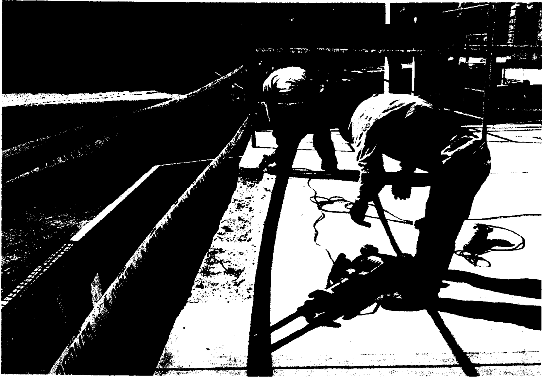
Señalización del área de trabajo
