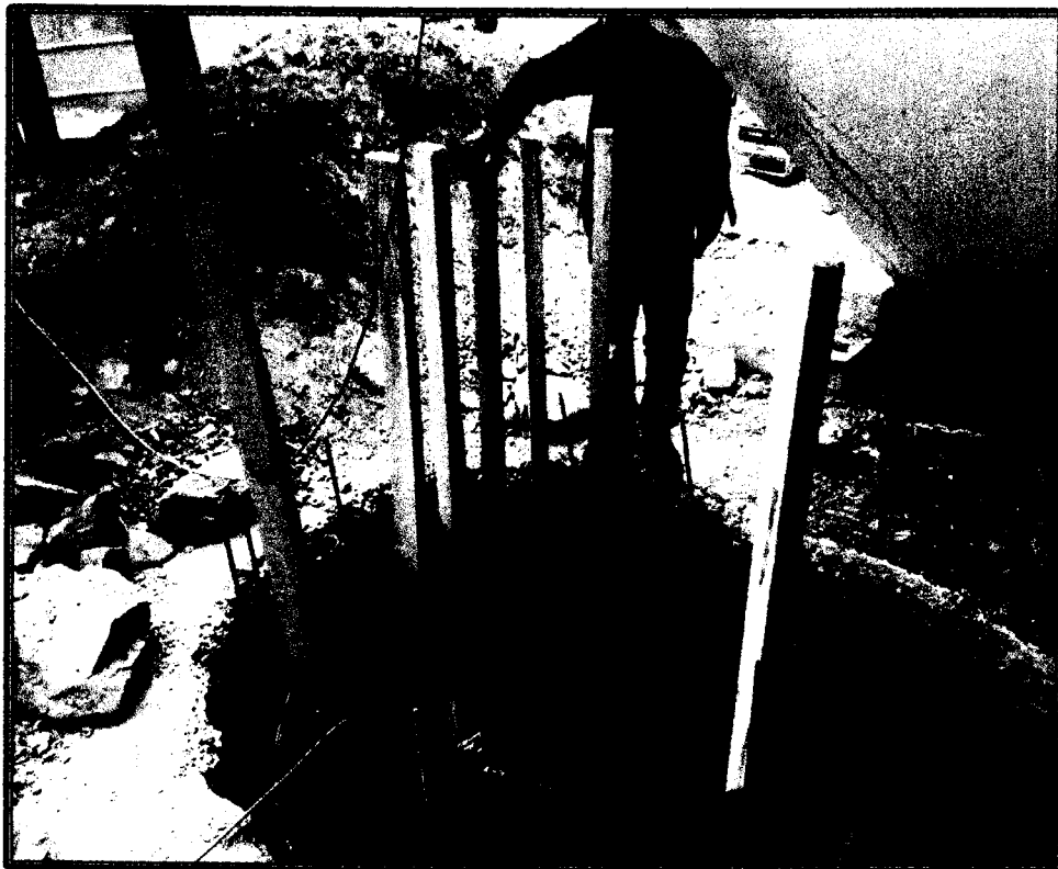
ENCOFRADO DEL POZO SUMIDERO
