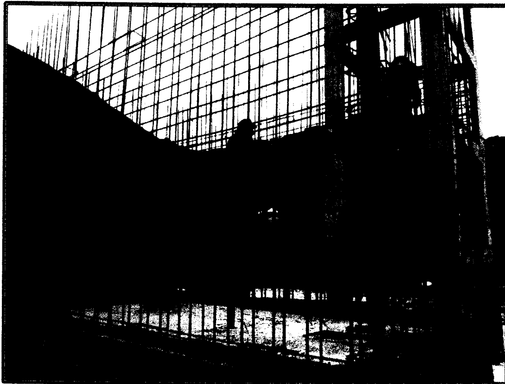
HABILITACIÓN DE ACERO DE MURO EN LA CISTERNA
