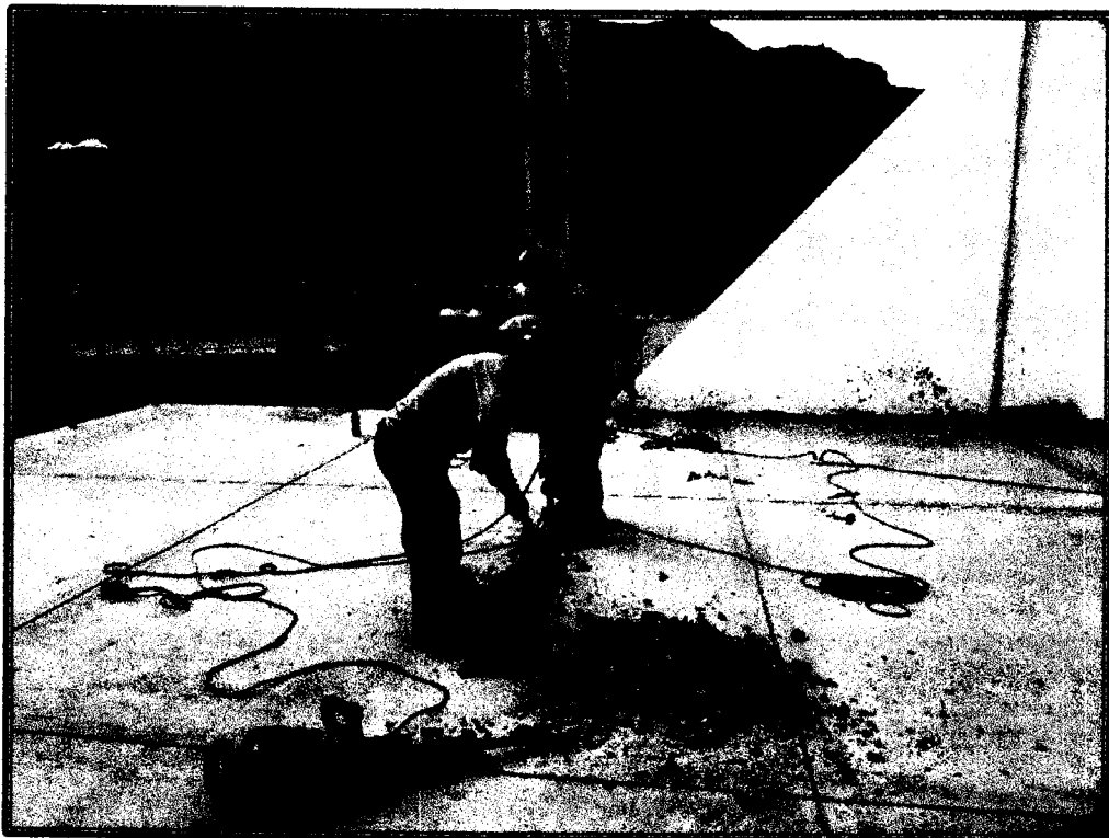
INICIO DE PICADO DE LA LOSA DE CONCRETO
