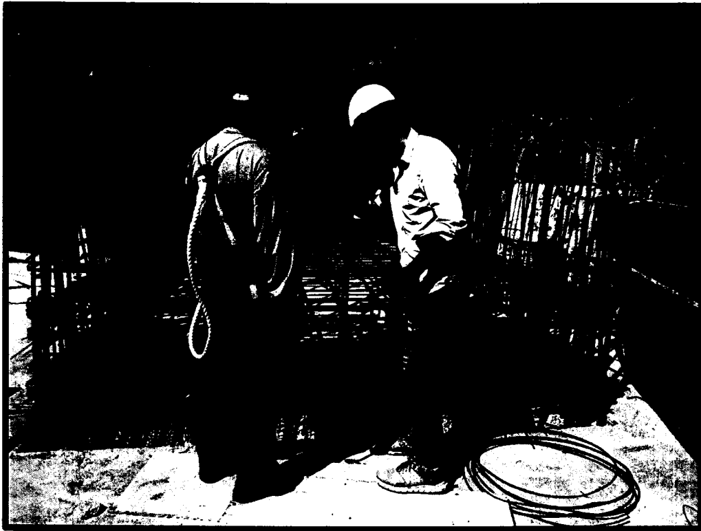
Fotografía 9. Trabajos de acero corrugado F_y=4200\text{kg/cm}^2 para losa de fondo de cisterna de agua salada
