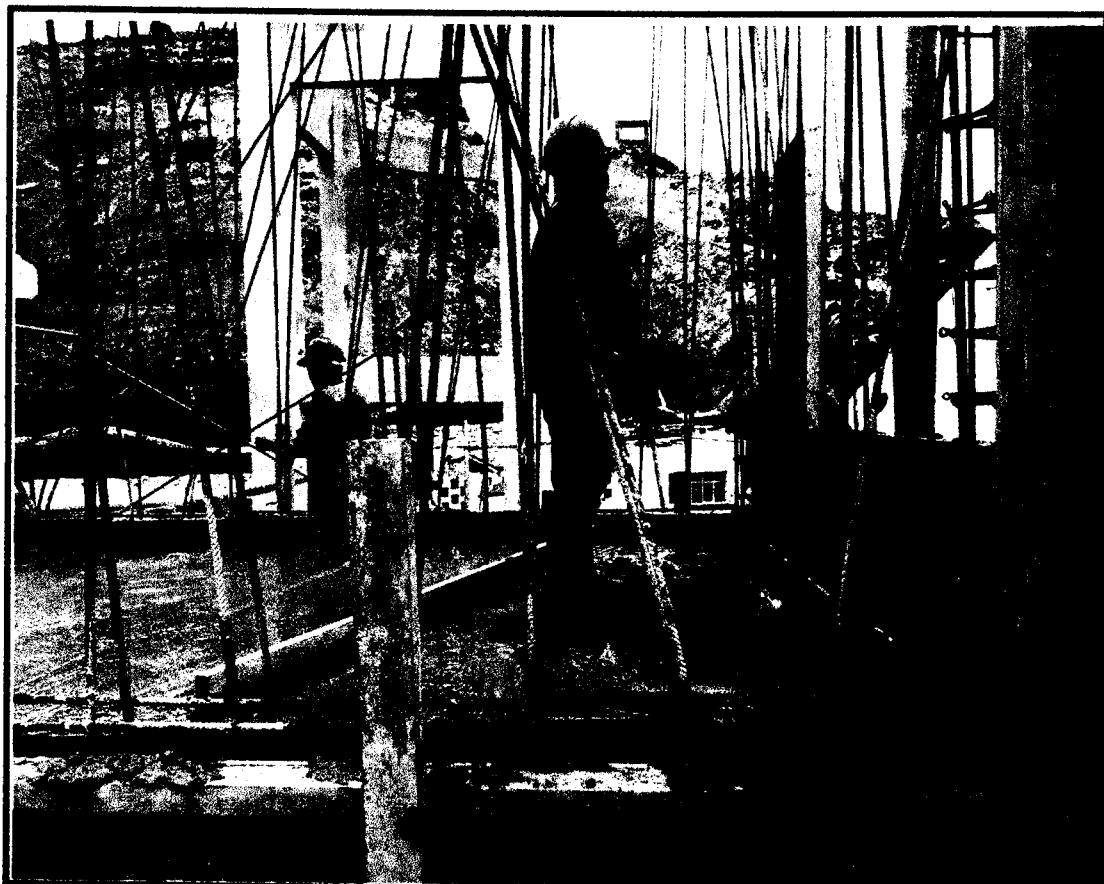
Fotografía N° 09. vaciado de concreto f'c=280\text{kg/cm}^2 en vigas
